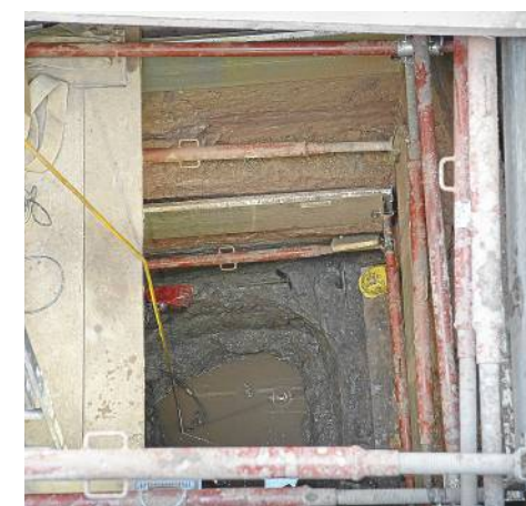
Blick in den 16 Meter tiefen Brunnenschacht.
